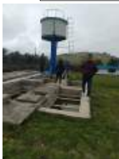
Inspección Junta Agua Potable Libertad
