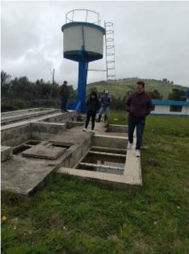
Inspección Junta Agua Potable Libertad
